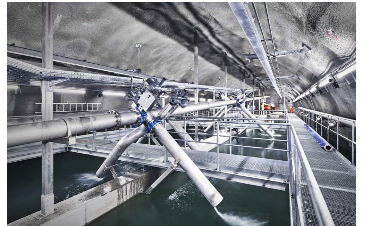
Absetzbecken mit Rohrleitungen und Schieber
