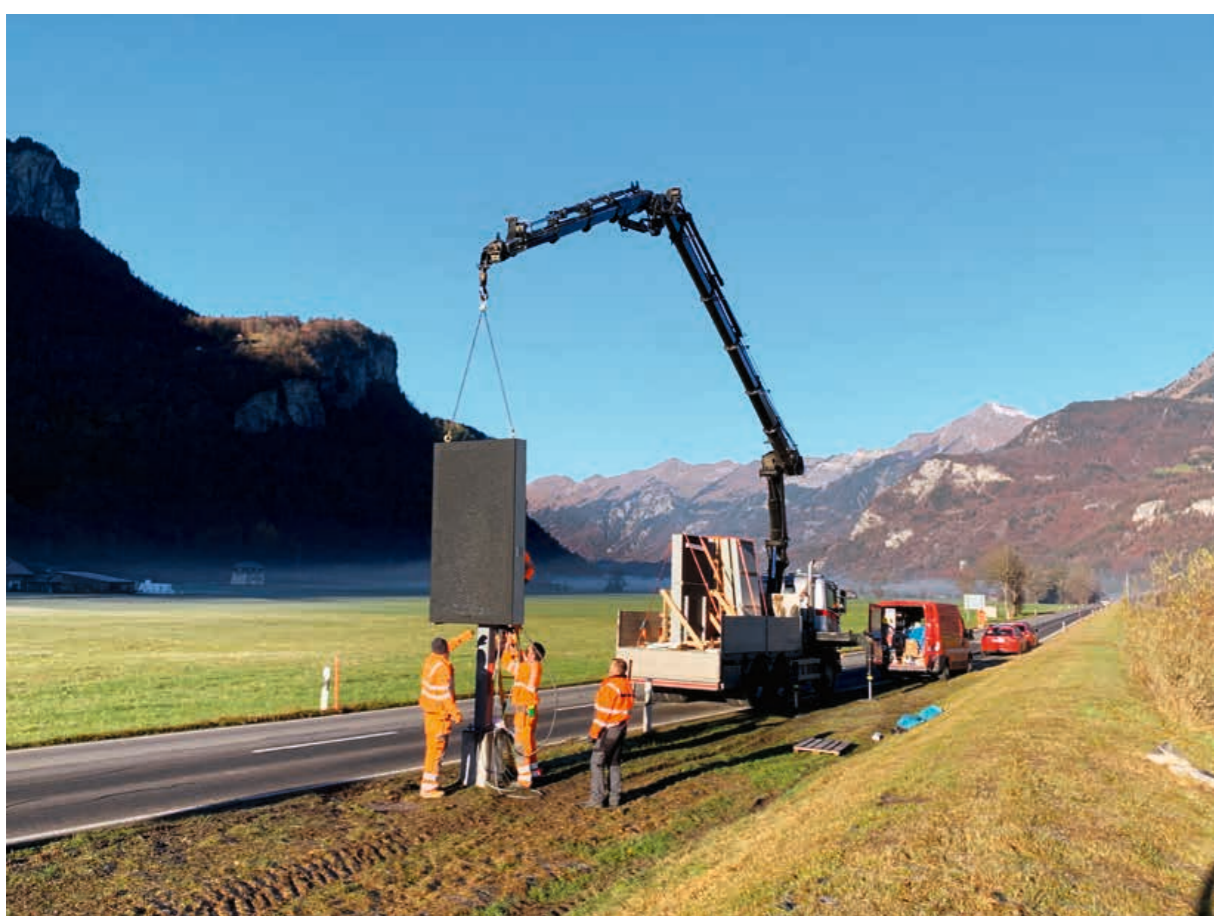
Montage von Stahlmast mit Signal
