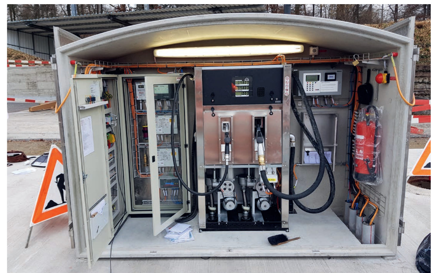
Lubox-Kabine während der Installationsarbeiten
