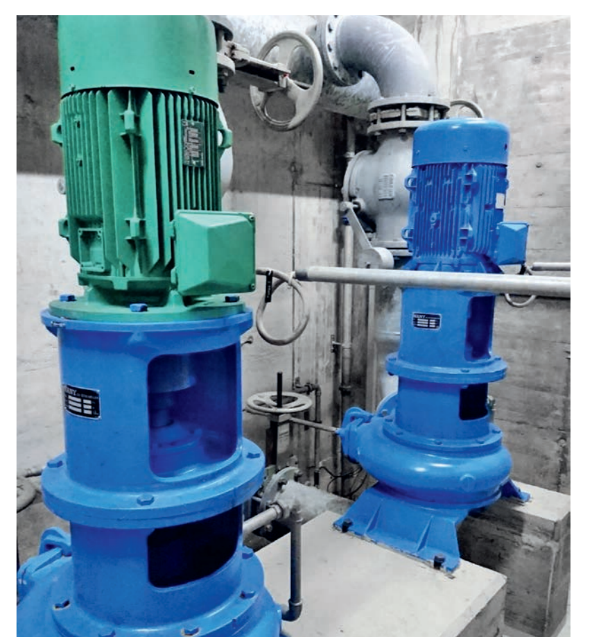
Pumpen für Tunnelwasser
