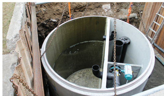
Platzieren des Ölabscheiders
