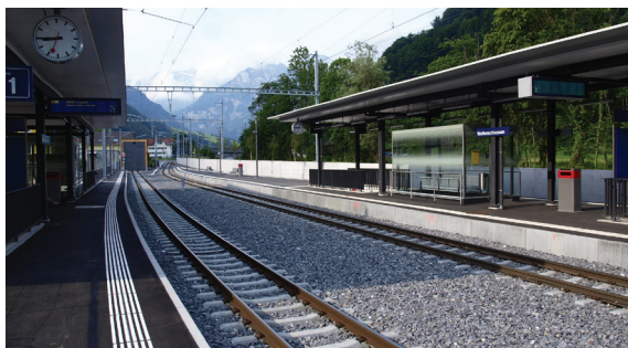
Perron-Gleisanlage Richtung Engelberg
