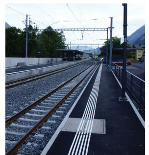
Gleisanlage Richtung Stans
