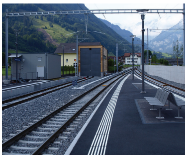
Gleisanlage mit Technikraum & Remise im Hintergrund
